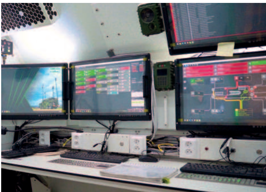
Operátorské pracoviště při dokončovací montáži a oživení
