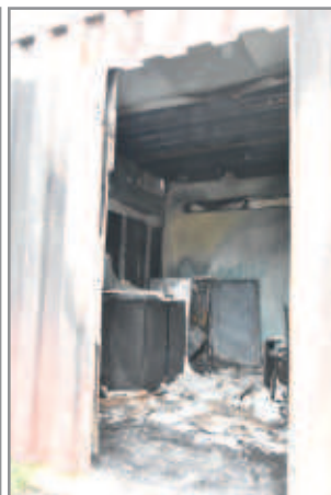
Výuková místnost v lodním kontejneru po požáru.
