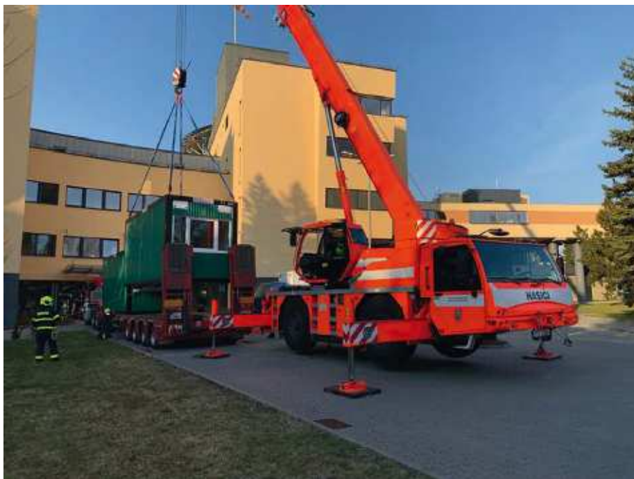
Výstavba fixního odběrového místa v nemocnici ve Frýdku-Místku
