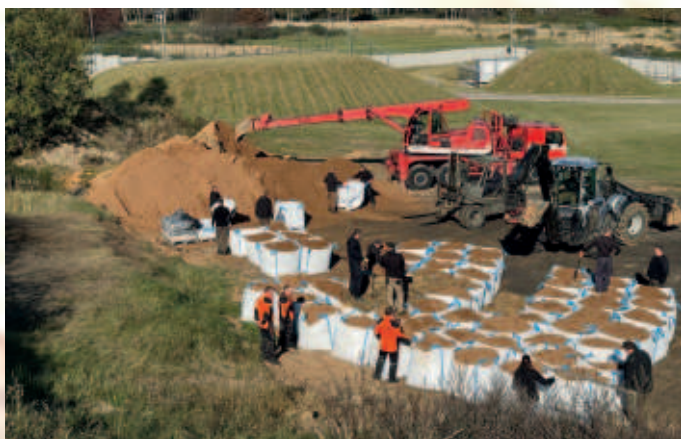
Výcvik eliminace střepinového efektu při ničení letecké pumy
