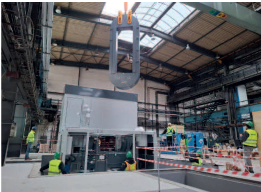
PBS Velká Bíteš – instalování HIP pece Quintus v nové hale DLT2 II.
