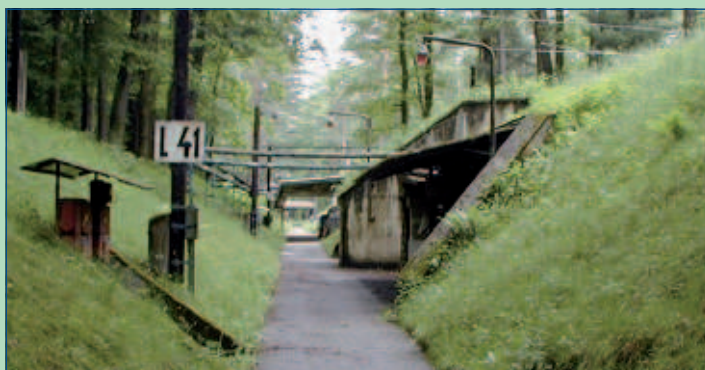
PRUNA - výroba, kde vzniká většina plastických trhavin Semtex® PRUNA – the facility where most Semtex® plastic explosives are made
